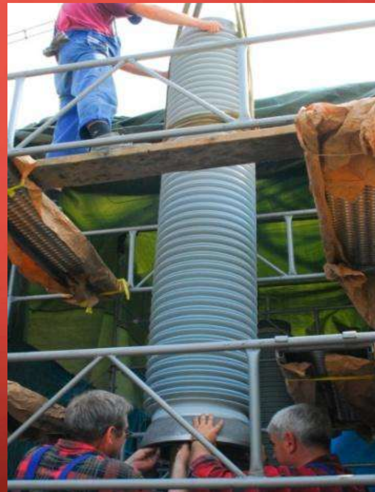
MONTAŻ GŁOWIC NA BUDOWIE
