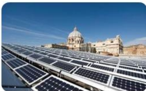
Instalacja na dachu papieskiej sali audiencyjnej w Watykanie
