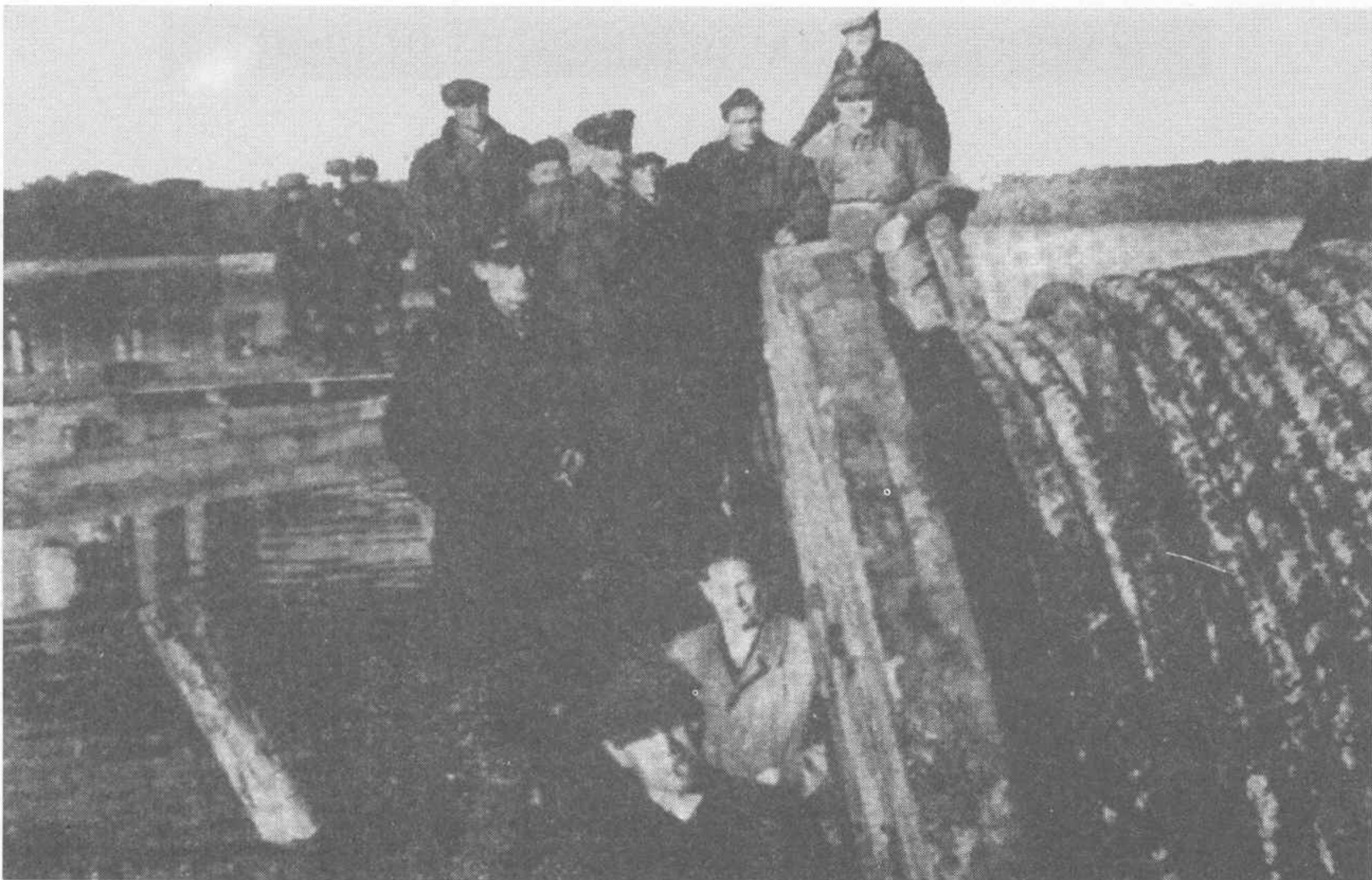
Przeprowadzenie kabla przez jezioro w Iławie - 1951 r. [2. str. 66]
