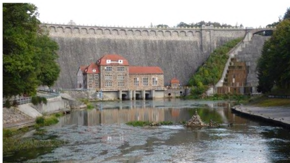
Elektrownia wodna w Pilchowicach na rzece Bóbr. (zdjęcie kol. Dariusz Stecki)
